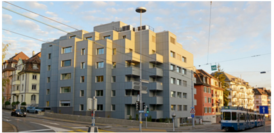
Sanierung mit räumlicher Erweiterung MFH Hofwiesen-/Rothstrasse in Zürich mit Photovoltaikfassade – die zwei obersten Geschosse sind als Holzelementbau, die unteren Geschosse in Massivbauweise erstellt.
